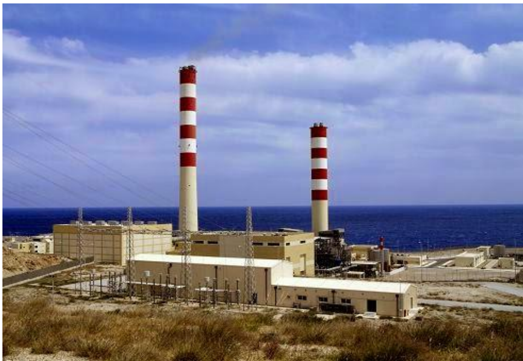
Ατμοηλεκτρικός σταθμός ΔΕΗ έξω από το Ηράκλειο.
